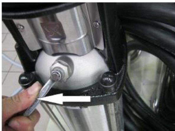
图 4-3: 关闭排气螺丝
