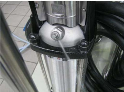
**Ilustración 4-2: Se ajusta el flujo de agua constante**
